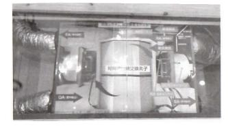
クトレス工法」で 2階の床下へ空気 を送っている。同 様に2階床の給 気口からも吐き出 される。
